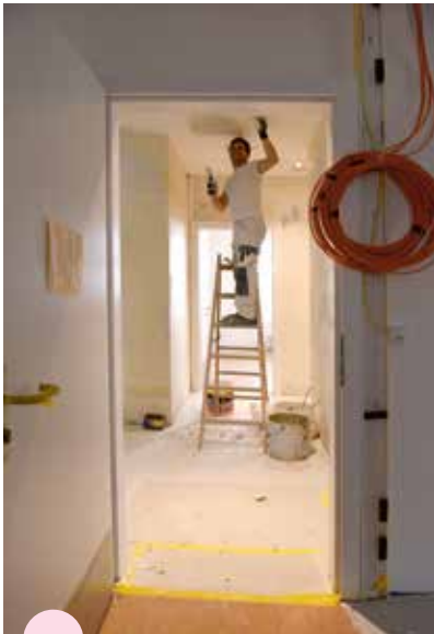
L'ancien EMS Recordon est en cours de rénovation pour accueillir des équipes de recherche.
